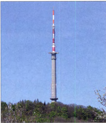
Der 162 m hohe Sendeturm aus Stahlbeton auf dem 449 m hohen Schafberg
