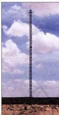
Radio Puntland sendet über einen Rundstrahler
