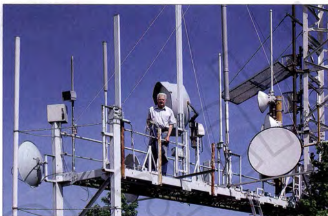
Antennenbrücke auf der 793 m hohen Lausche, Ost Sachsen; die Brücke entstand damals, um die Antennen 4 m anzuheben, und diente gleichzeitig als Diebstahl- und Randalierschutz. Zurzeit nutzen Mobilfunkanbieter, die Telekom sowie Funkamateure (ATV- und FM-Relaisfunkstelle DB0LAU, hier DM2CFL bei Antennenarbeiten) die Brücke.
